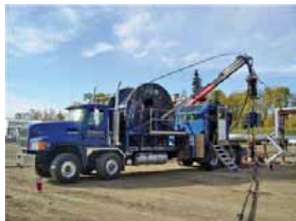
图2:位于加拿大的一个蒸汽辅助重力泄油(SAGD)井正在部署井下传感器,光缆与一个大型绕管和其他传感器集成在一起。整个传感器“串”用服务钻机注入井下。
