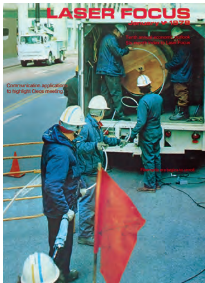
图2：技术人员安装光缆，用于AT&T的芝加哥现场试验。
